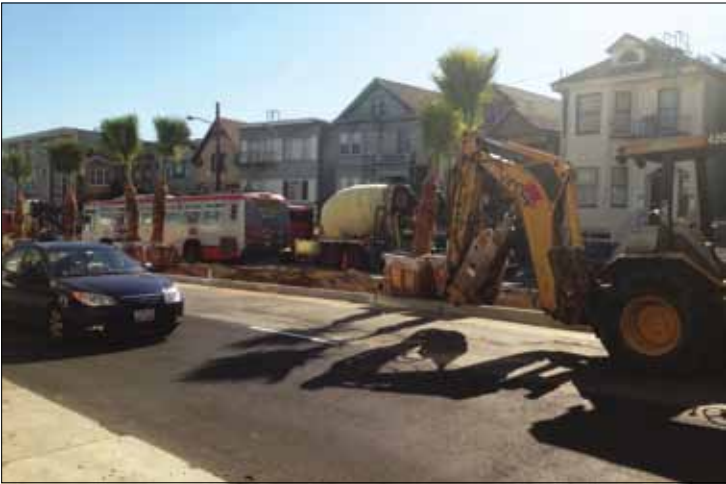
Palmeras plantadas a lo largo de la calle César Chávez como parte del proyecto de mejora al paisaje urbano. Palm trees are being added along Cesar Chavez Street as part of the street improvement project. Photo Olympia Zampathas
