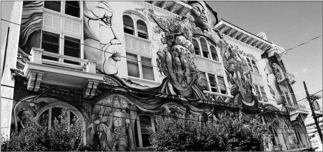
Mujeres Unidas y Activas está ubicada al interior del Edificio de las Mujeres en la calle 18. Mujeres Unidas y Activas is located inside the Women’s Building on 18th Street. Photo Courtesy www.thewomensbuilding.org
